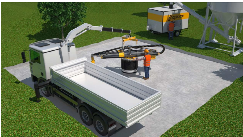
Рис. 6. Установка строительного принтера
