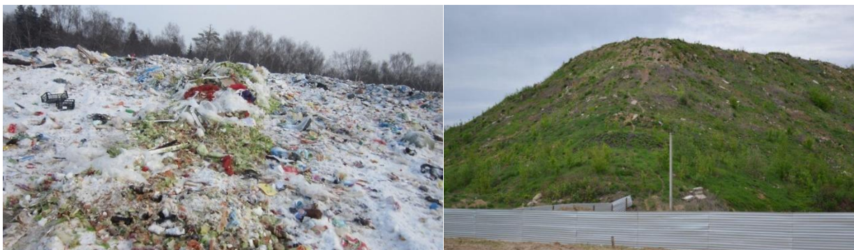
Рис. 5. Территория полигона «Некрасовка» до рекультивационных мероприятий.
