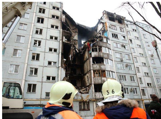
Рис. 8. Фрагмент подъезда после обрушения конструкций.
