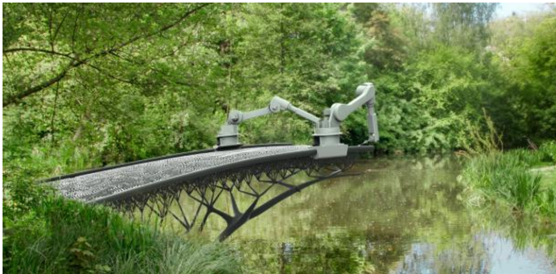
Рис. 3. Стальной мост компании MX3D
