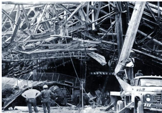
Рис. 4. Деформированные стальные конструкции после пожара
