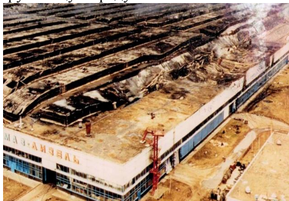
Рис. 3. Фрагмент панорамы завода двигателей после пожара
