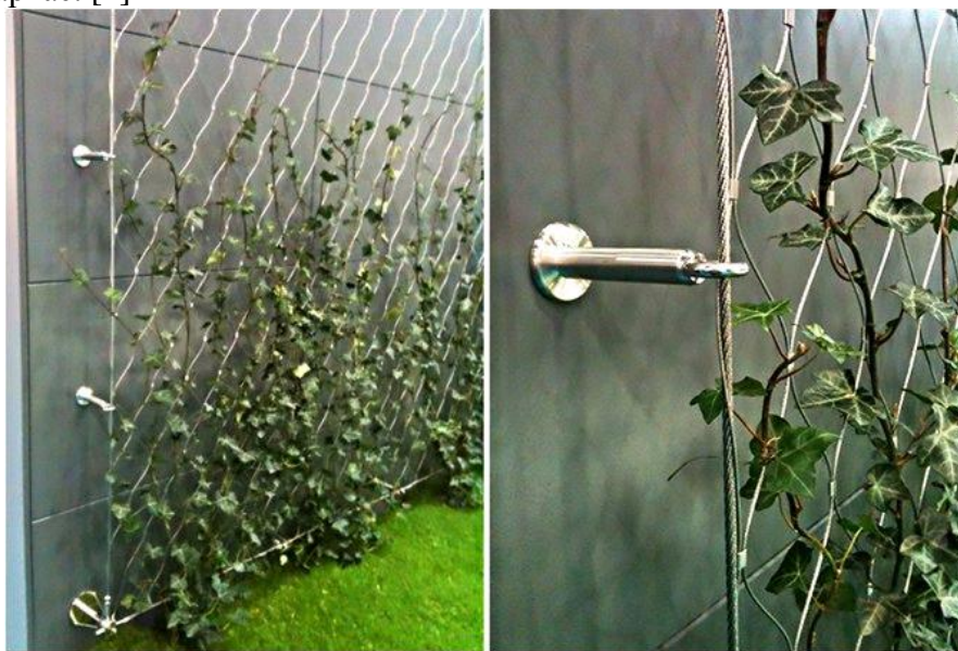
Рис. 2. Конструкции традиционного вертикального озеленения
