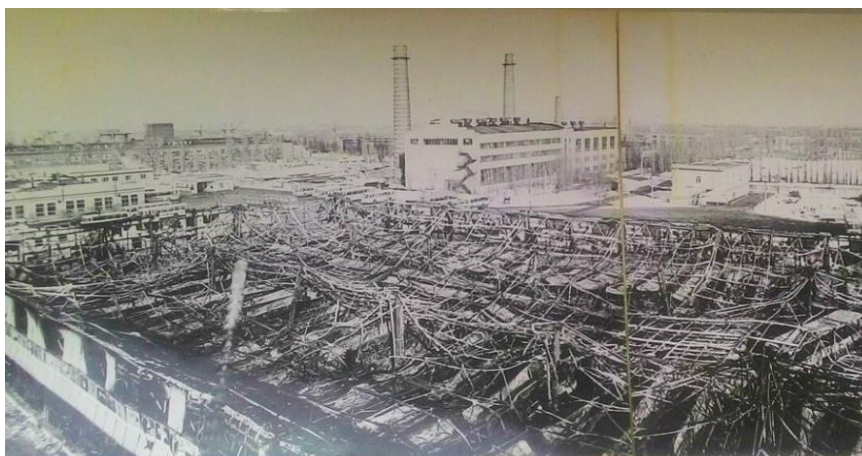
Рис. 5. Вид на гараж автотранспортного предприятия ПАТП-3 после пожара. Под стальными конструкциями видны остовы сгоревших автобусов
