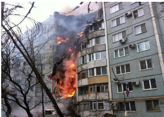
Рис. 7. Фрагмент подъезда после взрыва и последовавшего пожара.
