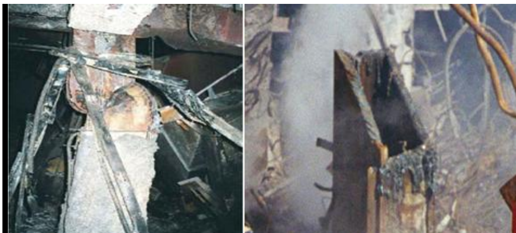
Рис.4.Деформированная колонна Рис.5.Остаток колонны после разбора завала
